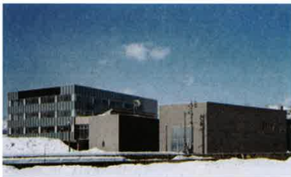
庁舎全体（左：本館 右：雪室）
