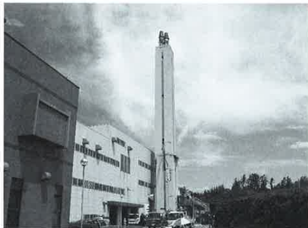
煙突の被害（中越沖地震・柏崎市）
