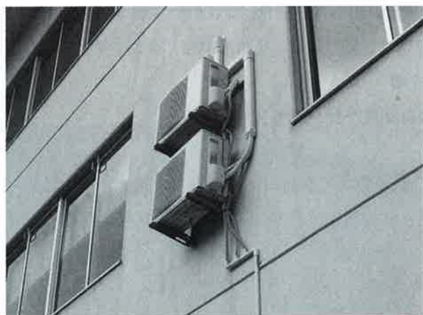
室外機・被害なし（能登半島地震・穴水町合同庁舎）
