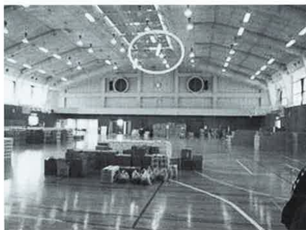
体育館の照明の脱落（能登半島地震・門前町）
