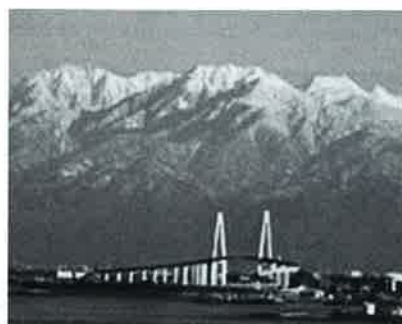
立山連邦・新湊大橋
