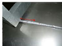
Cシステム 160mmの可動量 可動後は元の位置に戻っている
